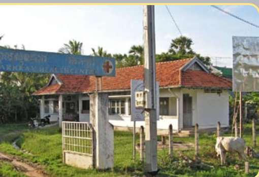
Jedno z center, kam jsme dodali základní vybavení porodnického sálu a zajistili tekoucí vodu
