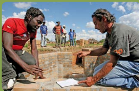
Naši pracovníci kontrolují základy nové školy.
